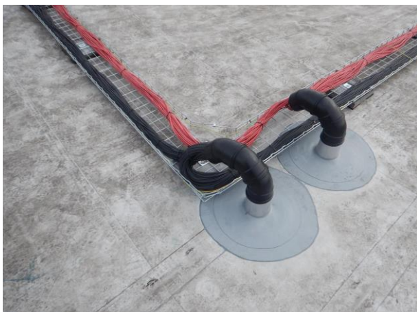
Figuur: Voorbeeld van een open draadgoot voor DC-bekabeling met gescheiden plus en min.
